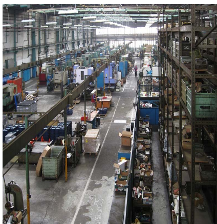
Pohled do obrobny objektu výrobní haly
